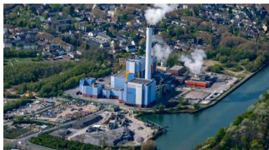
Eine Müllverbrennungsanlage im Ruhrgebiet.
