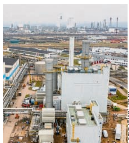
Industrieanlagen wie hier in Leuna soll der Brennstoffwechsel erleichtert werden.
