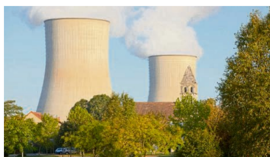
Viele AKW - wie das in Civaux - wurden abgeschaltet. © picture-alliance/dpa/B.trand Bechard
