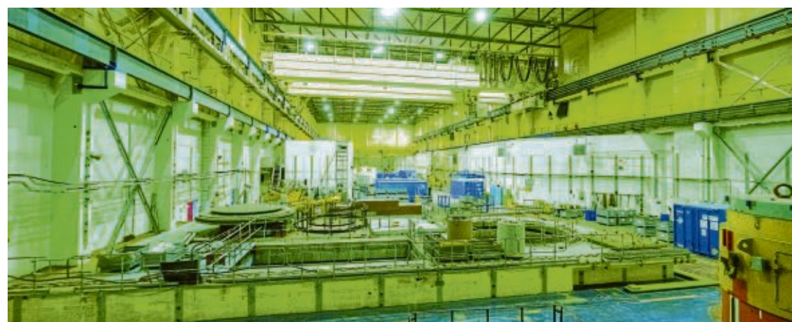
Zwischen Vergangenheit, Gegenwart und Zukunft – das Atomkraftwerk Lubmin erfuh den größten Rückbau eines europäischen Kraftwerks.
