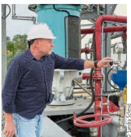
Vulcan-Deutschland-Chef Horst Kreuter im Geothermiekraftwerk Insheim.
