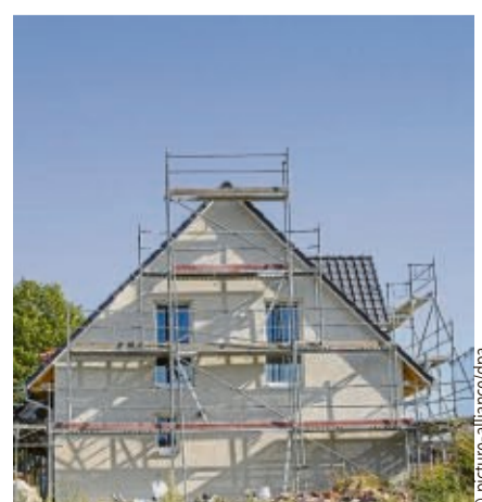
Eine Novelle des Baugesetzbuches soll den Wohnungsneubau beschleunigen.
