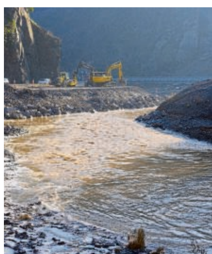
Die Aufbauarbeiten im Ahrtal dauern an.
