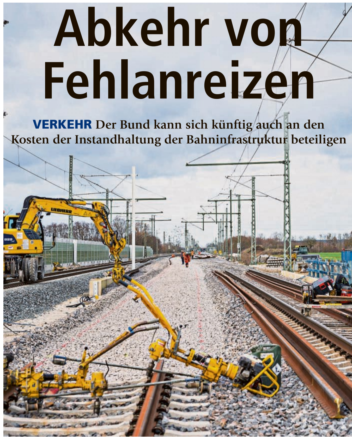
40 besonders belastete Streckenkorridore sollen bis 2030 generalsaniert werden.
