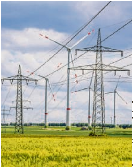
Freileitungen für den Stromtransport
