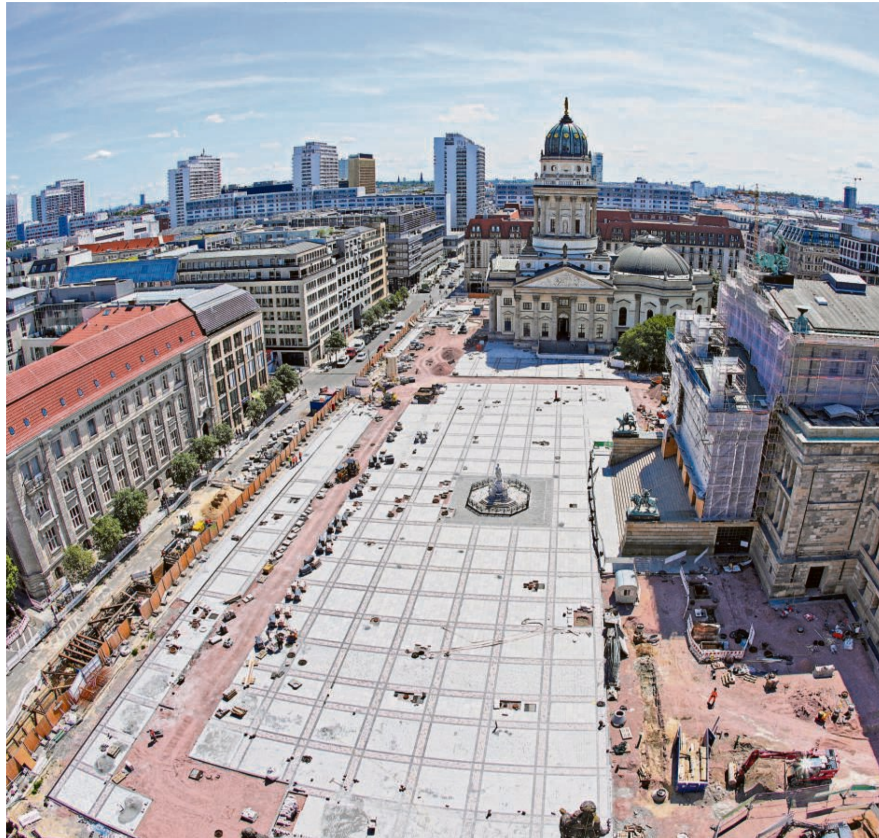
Noch sind die Bauarbeiten auf dem Berliner Gendarmenmarkt nicht abgeschlossen. Der Platz erhält unter anderem ein wasserdurchlässiges Pflaster. © picture-alliance/dpa/Soeren Stache
