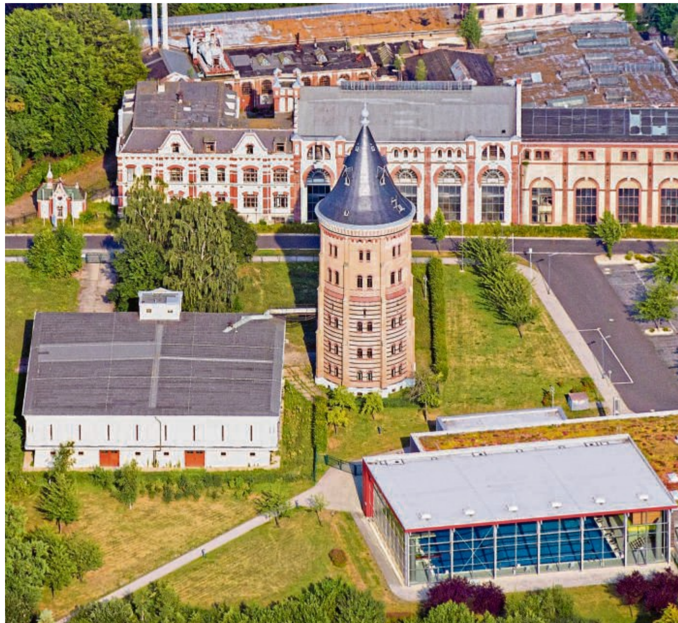
Bis zu 400 Kubikmeter fasst der 30 Meter hohe Wasserturm im sächsischen Görlitz, der seit 1892 in Betrieb ist. © picture-alliance/ZB/eurorulfbild.de/B. Clemens
