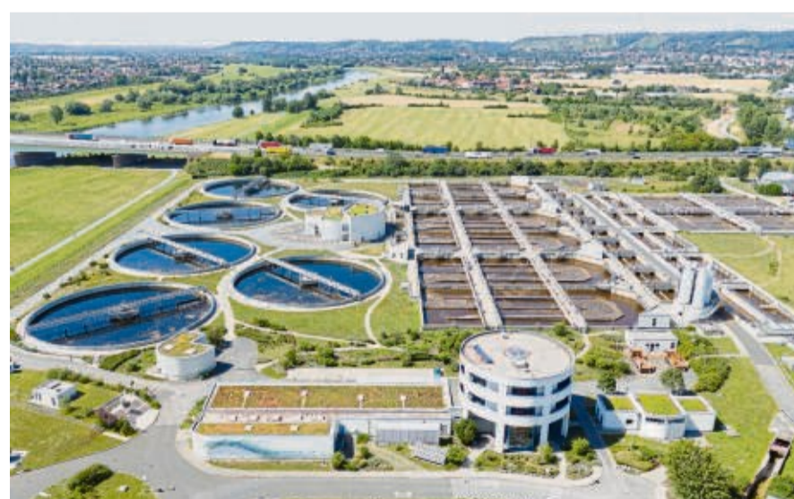
Eine moderne Kläranlage der Stadtentwässerung Dresden © picture-alliance/dpa| Sebastian Kahner
