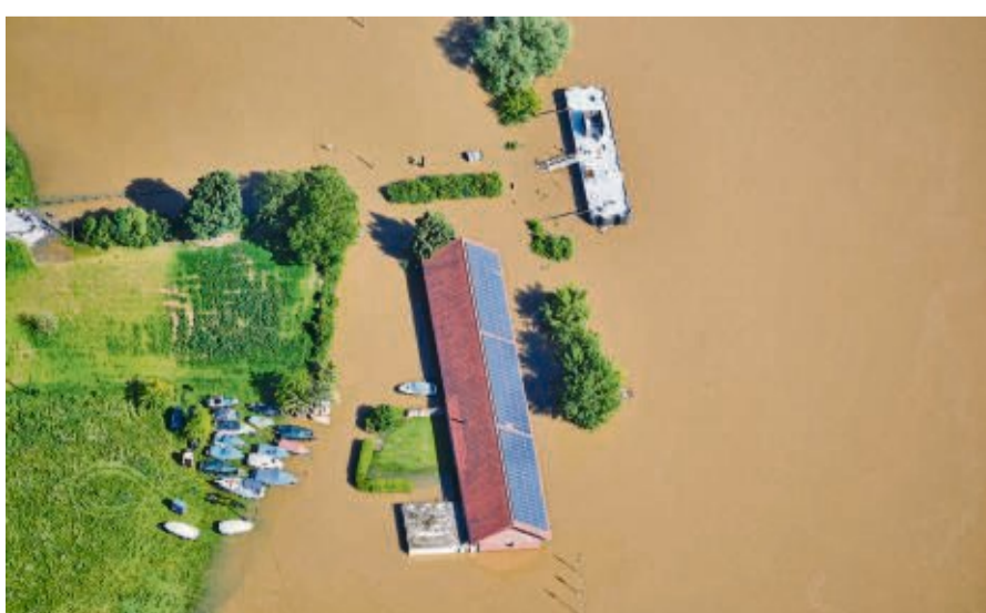
Hochwasser nach Starkregen in Bayern im Juni 2024: Extremwetterereignisse sind eine Folge des Klimawandels.
