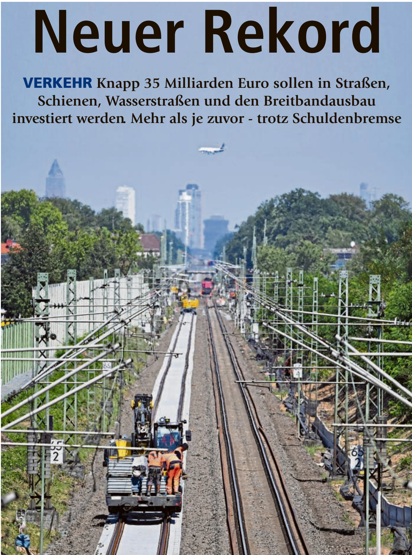
Generalsanierung der Riedbahn: „Auf diese Baustelle schaut die Welt“, sagt der Verkehrsminister.
