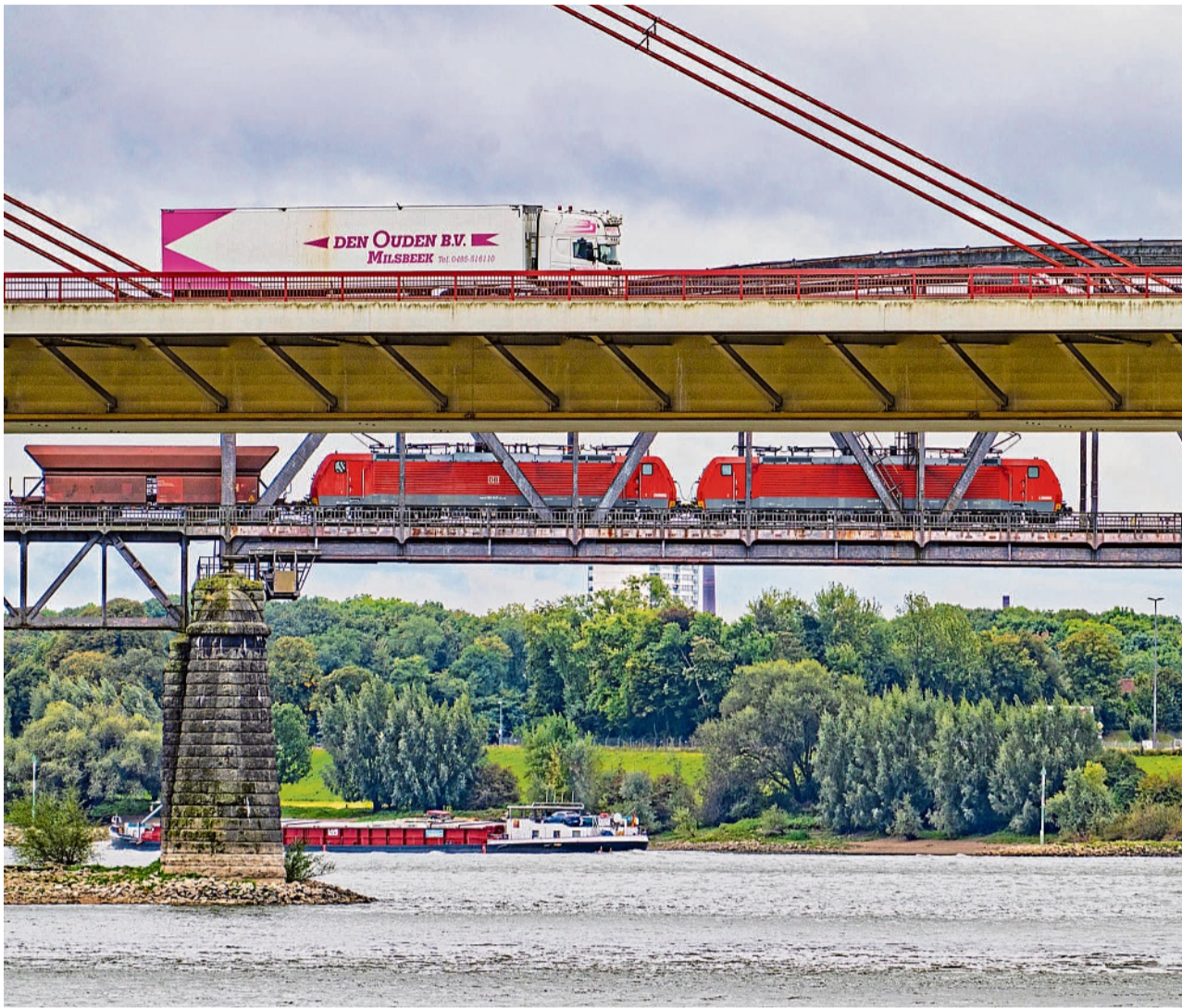
In Schienen, Straßen, Flüsse, Kanäle und Brücken können 2025 bis zu 35 Milliarden Euro investiert werden.
