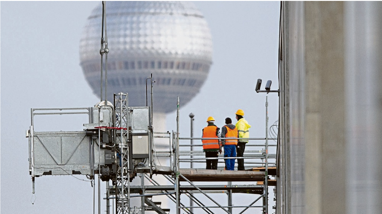
Baustelle am Marie-Elisabeth-Lüders-Haus des Bundestages: Firmen, die sich um Aufträge des Bundes bewerben, müssen künftig Tarifverträge vorlegen. Das Gesetz sollte ursprünglich bereits am 1. Januar 2026 in Kraft treten.
